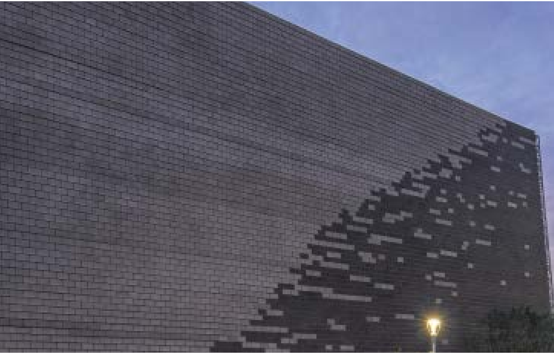
Varied CMU Brick Wall Muro de ladrillos CMU variados
